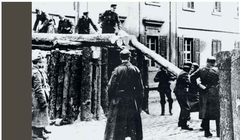
Bau einer Panzersperre in Frankfurt (Oder); rechts Festungskommandant Oberst Ernst Biehler. Entlang Oder und Neiße werden ...
